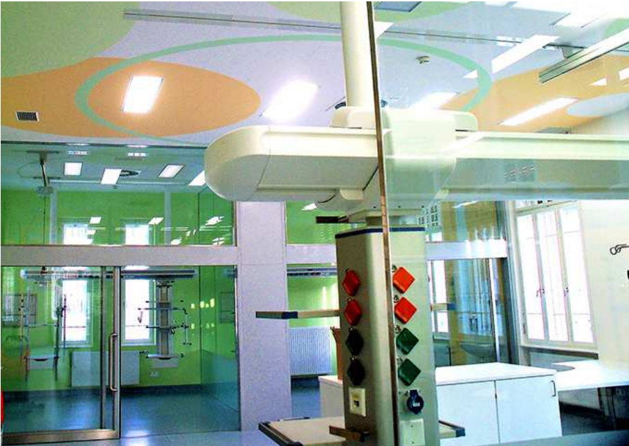
Abb. 6: Licht- und Farbgestaltungen im Krankenhaus Graz
